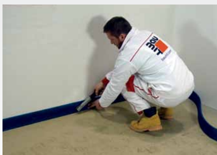
1. Montarea benzilor de etanșare
