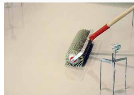
6. Dezaerarea suprafeței cu rolă cu țepi
