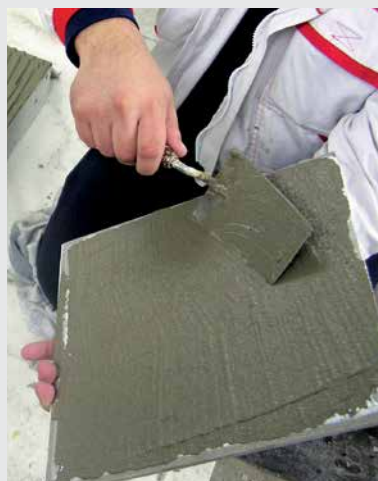
Metoda „Buttering-Floating“
