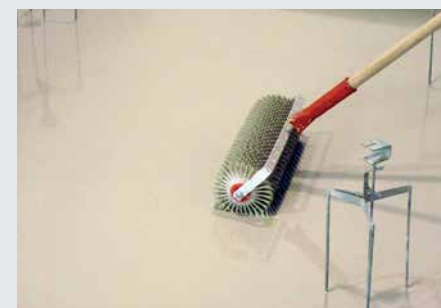
6. Dezaerarea suprafeței cu rolă cu țepi
