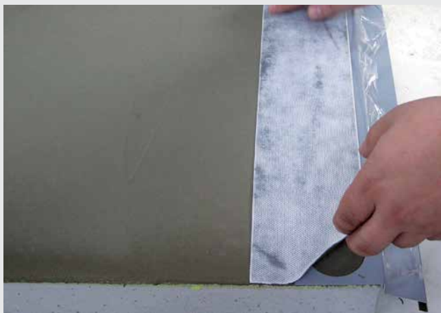
2. Instalarea benzii de etanșare pe balcon la profilul cu picurător marginal
