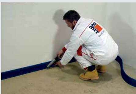
1. Montarea benzilor de etanșare
